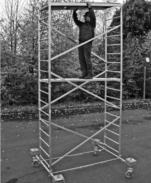
Heng deretter plattformen med de tiltenkte åpningene i de øverste tverrstykkene på vertikalrammen. Trekker deretter til de allerede monterte sikringssettene.
