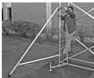
Na zdjęciu sposób zamontowania podpory.
