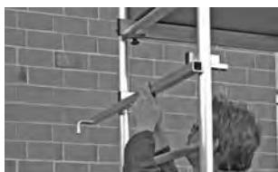
La ilustración muestra la instalación de distanciadores a la pared.
