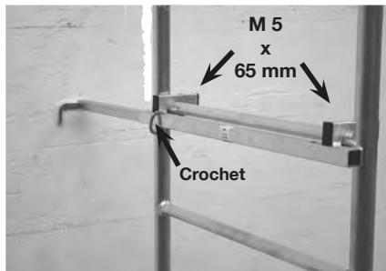
Monter le kit de stabilisation sur la barre au-dessous de la plate-forme de travail la plus haute.
