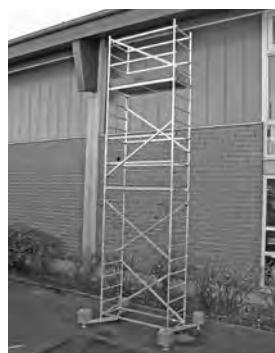
Basisplatform met eerste en tweede slag
