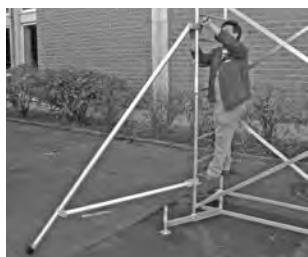
Op de foto is het aanbrengen van de stabilisatoren te zien.
