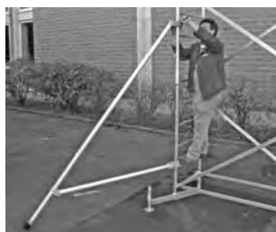
La ilustración muestra la instalación de salientes.
