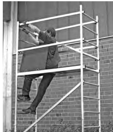
Базовая конструкция с первой надстройкой
