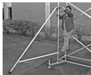
Kuvassa näytetään seinävälikkeiden asentamisen.
