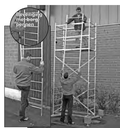
Basisplatform met eerste en tweede slag
