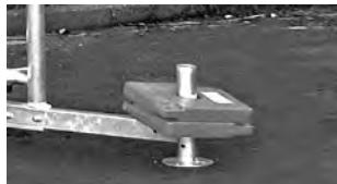
Bilden visar pålagd ballast på traversen.
