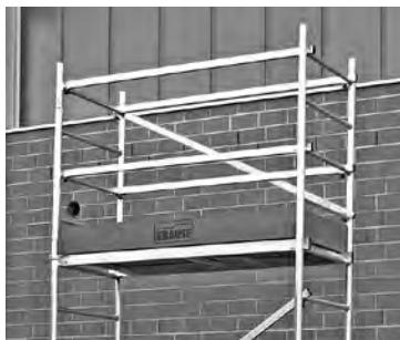
Базовая конструкция с первой надстройкой
