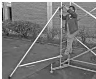
Kuvassa näytetään seinävälikkeiden asentaminen.
