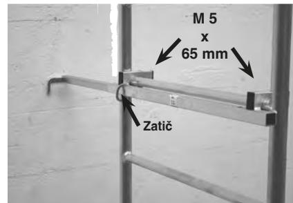
Oder je možno s stabilizacijskim setom po potrebi pritrdati na steno. To je namenjeno dodatni stabilizaciji odra, vendar ne nadomešča predpisanih obtežilnih uteži oz. opornikov (glej stran 566). Za ta primer uporabe – zasidranje v steno – je treba uporabiti očesni vijak premera 12 mm. Vrsta vložka je odvisna od podlage.
