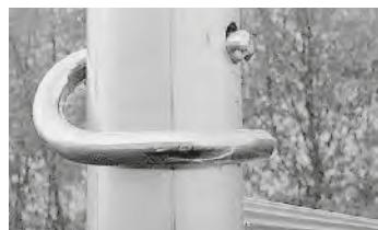
Alle Steckverbindungen müssen mit Fallsteckern gesichert werden.
