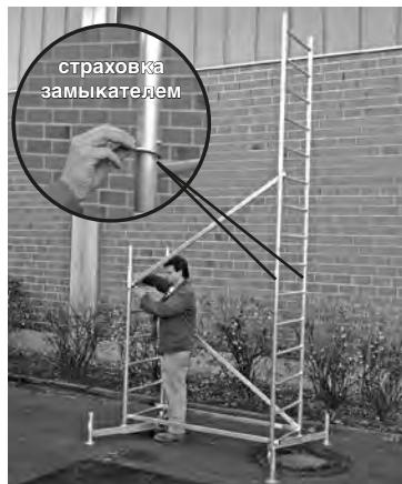
Базовая конструкция с первой надстройкой
