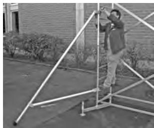
Şekilde destek kollarının donatılması gösterilmektedir.
