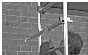
Şekilde duvar dayamalarının donatılması gösterilmektedir.
