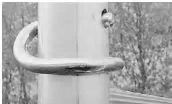
Alla stickförbindelser måste vara säkrade med låsanordningar.
