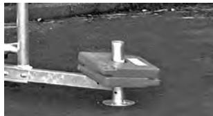
Na zdjęciu balastowanie stabilizatora.
