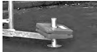
Slika prikazuje nameščanje opornika.
