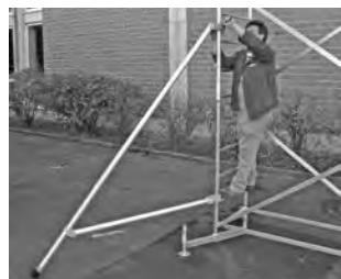
Obrázek ukazuje montáž stabilizační sadu.
