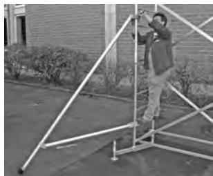
Obrázok ukazuje upevnenie výložníkov.
