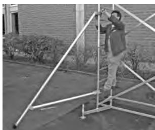
La ilustración muestra la instalación de salientes.
