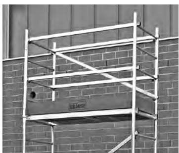
Die Abbildung zeigt den fertig montierten Seitenschutz.
