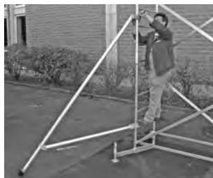
Şekilde destek kollarının donatılması gösterilmektedir.
