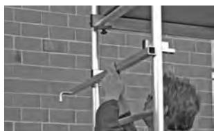
Obrázok ukazuje upevnenie stabilizačnej súpravy.
