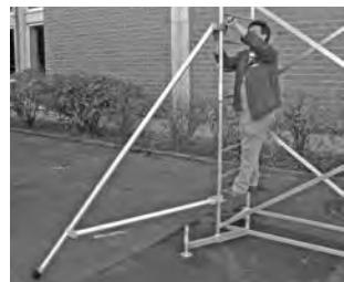
Obrázek ukazuje montáž stabilizační sady.
