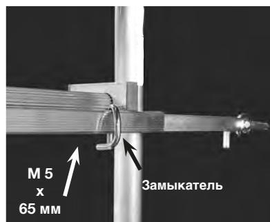
навесить якорную трубу в якорный рым-болт закреплённый на стене. Закрепить якорную крепёжную трубу к перекладине под верхним помостом. Застрахуйте страховочными зажимами Застопорить подвижную часть трубы замыкателем
