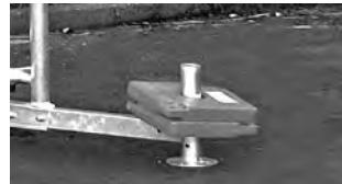
Obrázek ukazuje montáž stabilizátorů.
