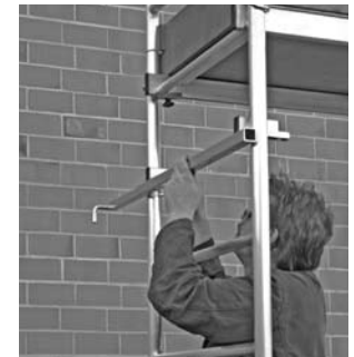
Grundgerüst mit erster und zweiter Aufstockung
