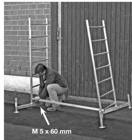
Grundgerüst mit erster Aufstockung
